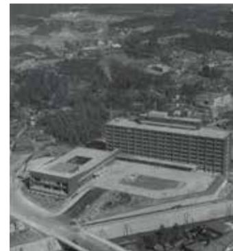
新築された三重県庁 (『県民グラフ』より、1964年)
