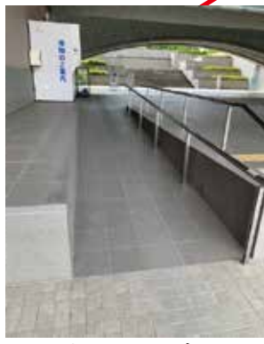
エントランス左 スロープ
