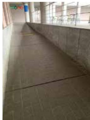
文化棟スロープ
