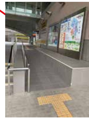
エントランス右 スロープ
