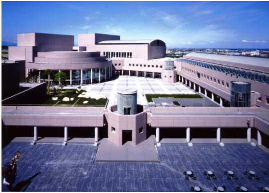
センター全体（奥が大ホール）
