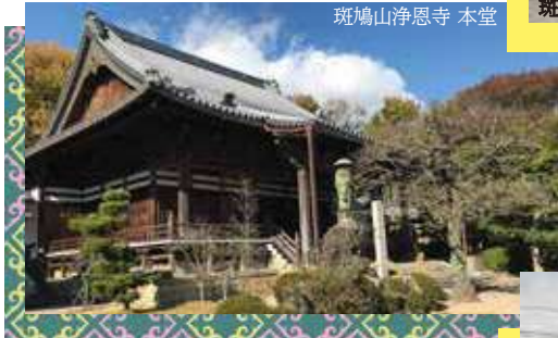
斑鳩山浄恩寺 本堂
